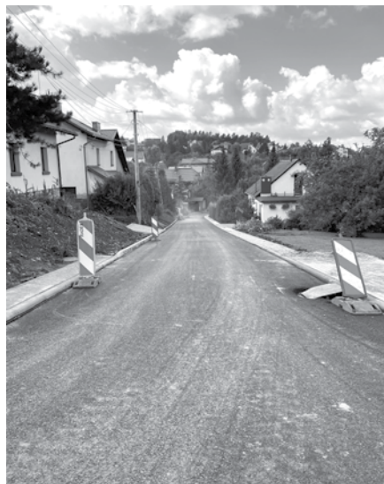
Ulica Zamkowa została poszerzona, przebudowano również zjazdy do każdej z posesji.
