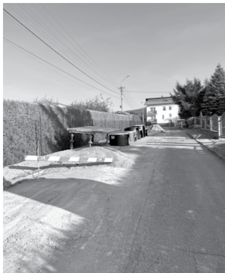
Od budowy kanalizacji deszczowej rozpoczęły się prace w ramach ulicy Storczyków.
