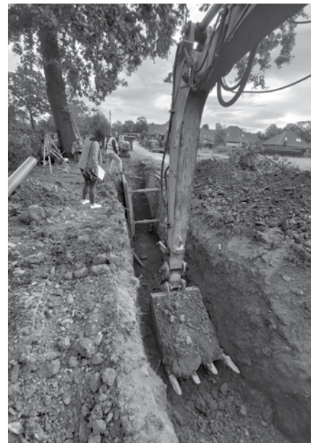
Prace budowlane prowadzone są m.in. w rejonie ul. Dolnej – Zadanie nr 2
